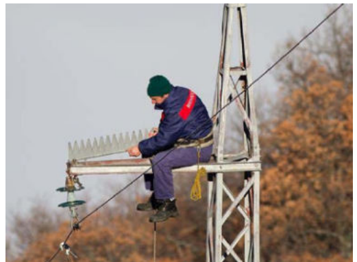
In Projektgebieten werden auf für Geier gefährlichen Hochspannungsleitungen zu deren Schutz Verschaltungen und Sitzbehinderungen angebracht.
