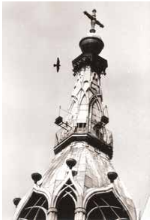
An der Marienkirche im Berliner Stadtzentrum (MÜLLER 1989) kam es Ende der 1980er Jahre im Prozeß der zunehmenden Verstärkung des Wanderfalken zu ersten erfolgreichen Bruten. FOTO: VERFASSER
