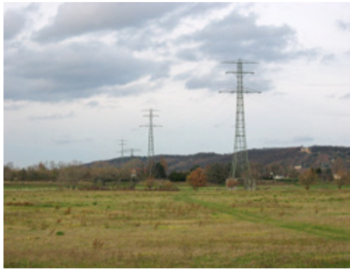
Abb. 10. Hochspannungsmast am Niederwarthaler Staubecken zwischen Dresden und Meissen, von dem aus in den 1950er Jahren überwinterte Wanderfalken regelmäßig die Rebhuhnjagd betrieben. Die Aufnahme ist neueren Datums.
