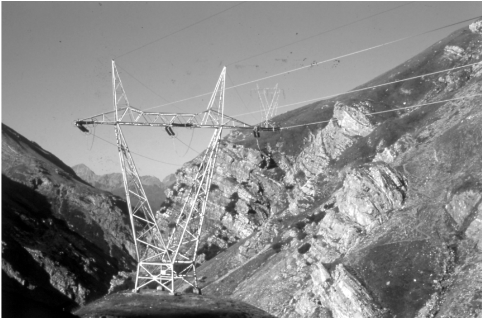
Die durch das Horstmassiv am Stilfser Joch verlaufende Hochspannungsleitung, an der die im Text beschriebene Auseinandersetzung zwischen Bartgeier und Kolkraben stattfand.
